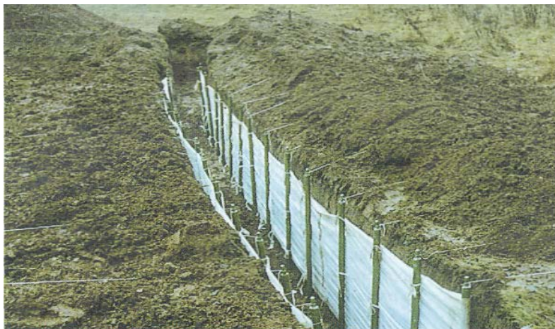
Рис. 3. Одежда крутостей траншей из унифицированных элементов промышленного изготовления УЭПИ-9
