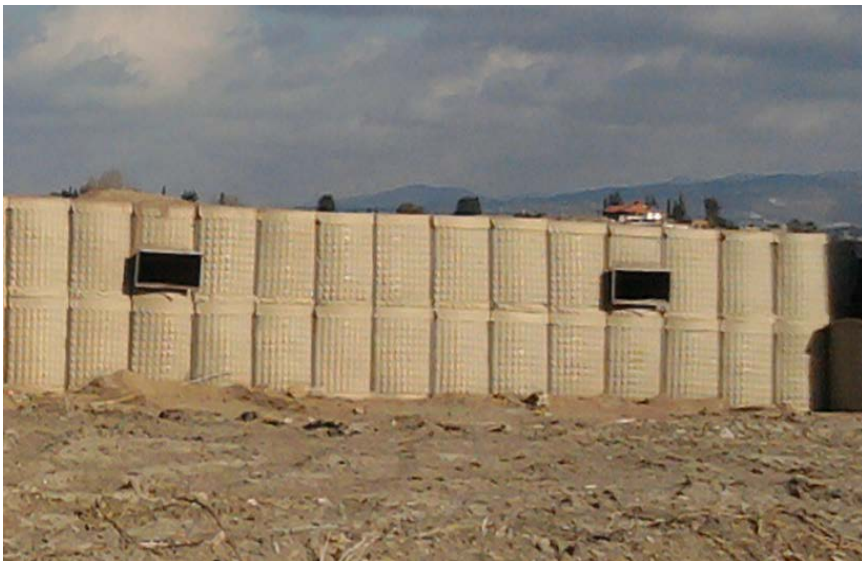
Рис. 5. Защитная стена из ГНТ с бойницами для стрельбы из автоматического стрелкового оружия
